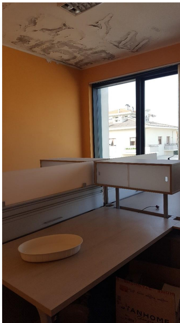
VISTA INGRESSO ATTESA LOCALE UFFICIO ARREDATO CON INFILTRAZIONI
